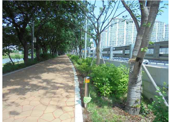
옹벽 종점측 상부
