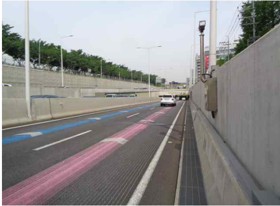
서부간선지하도로 성산방향 진입부
