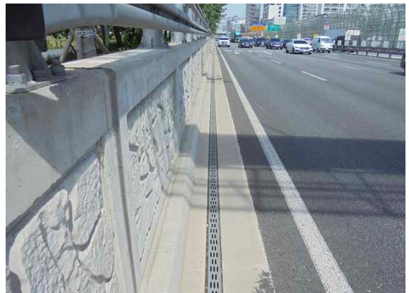
옹벽 종점측 하부
