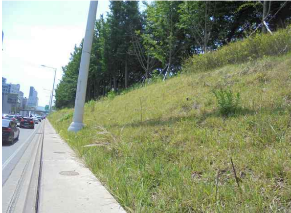
옹벽 시점측 상부
